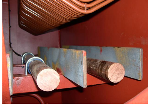
Figura 13. Las varillas de cobre (ánodos) y placas de acero (cátodos) del sistema ICAF se han de instalar de forma individual en la toma de mar antes de proceder con la instalación del enfriador de caja.
